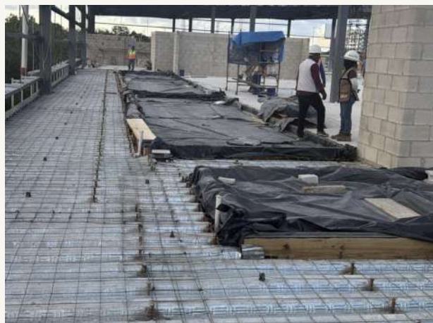
06 • Cimbrado especializado en áreas frigoríficas
